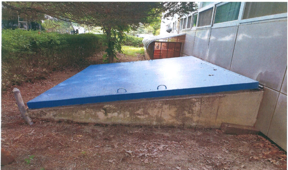
공사명 : 음성하수처리장 FRP뚜껑 교체공사 내 용 : 교체완료
