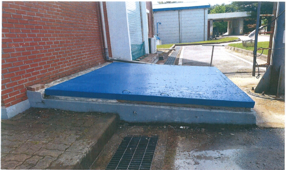
공사명 : 음성하수처리장 FRP뚜껑 교체공사 내 용 : 교체완료
