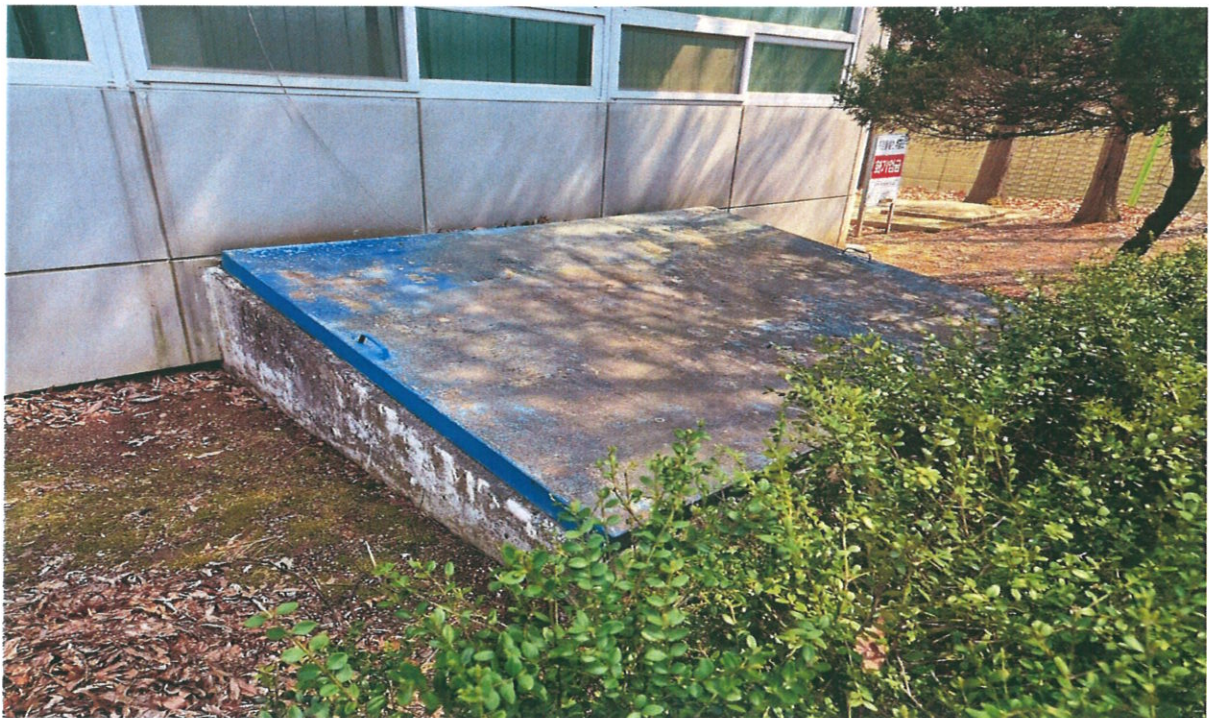
공사명 : 음성하수처리장 FRP뚜껑 교체공사 내 용 : 교체전
