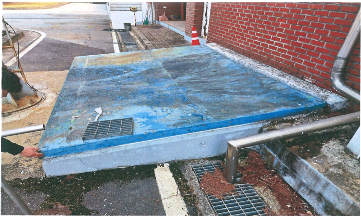
공사명 : 음성하수처리장 FRP뚜껑 교체공사 내 용 : 교체전
